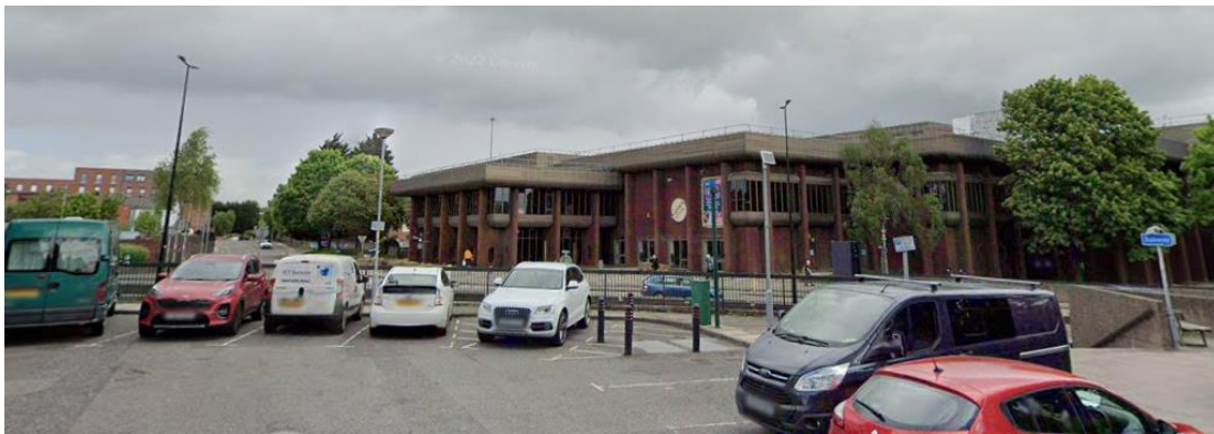
f) Delamere Street – CH1 4DS
